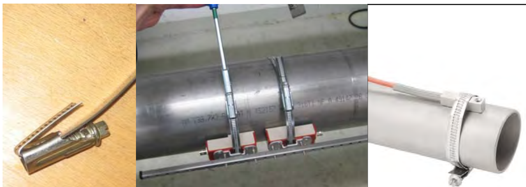
Abbildung 5 Bsp. Montage US- Wandler, PT100 mittels mitgeliefert Edelstahlbänder auf der Rohrleitung
