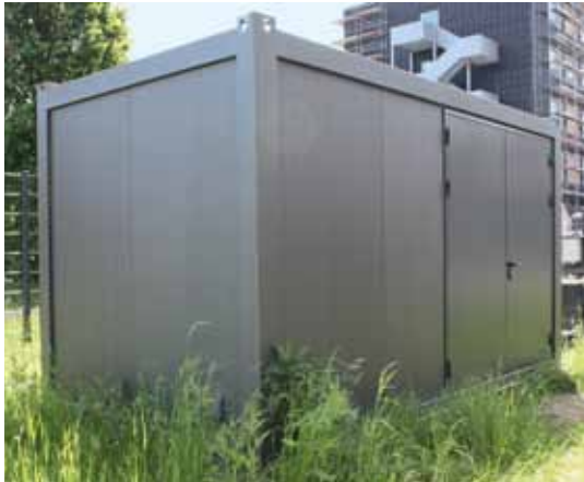
Zur Erfassung und Optimierung der thermisch-hydraulischen Versorgungssysteme Heizung, Warmwasser und Kälte wurde am PTW dieser Technikcontainer errichtet, in dem die Energieströme erfasst und bedarfsgerecht verteilt werden.
