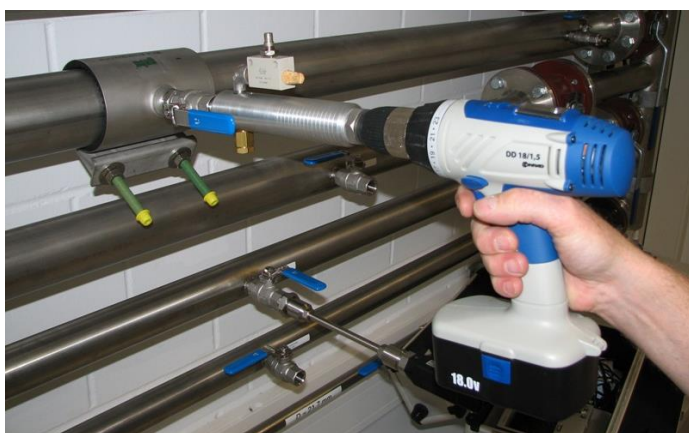
Bohren mit der Bohrvorrichtung Art.-Nr. 0530 1108
